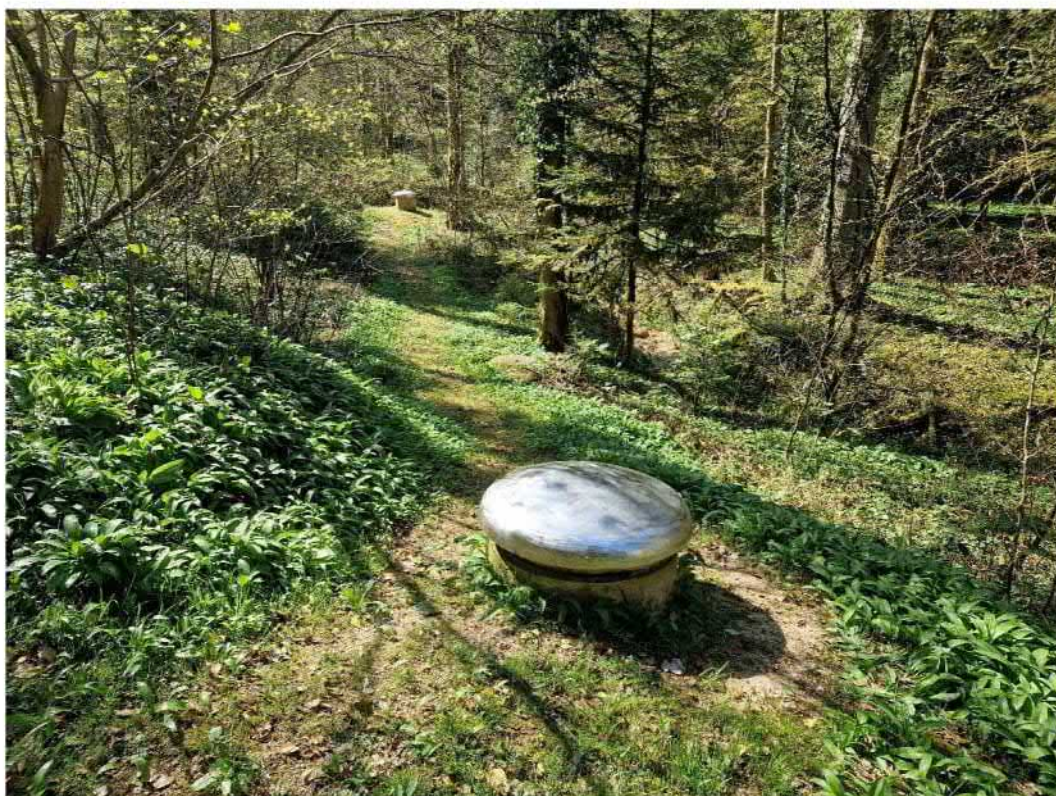
Foto 3: Schacht Quelle 2 (66.4.A) und 3 (66.3.A)
